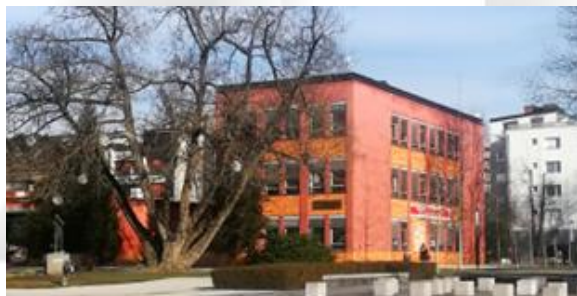
Budynek pilotażowy projektu eCentral - siedziba Uniwersytetu Trzeciego Wieku (Ljudska univerza Velenje)
